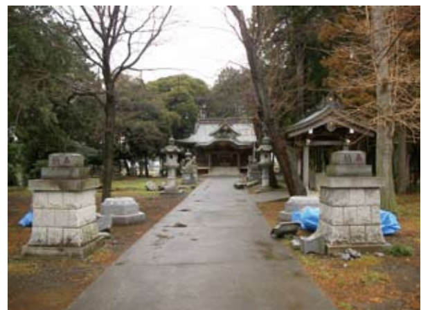
写真 1 小野崎八坂神社の被災状況
