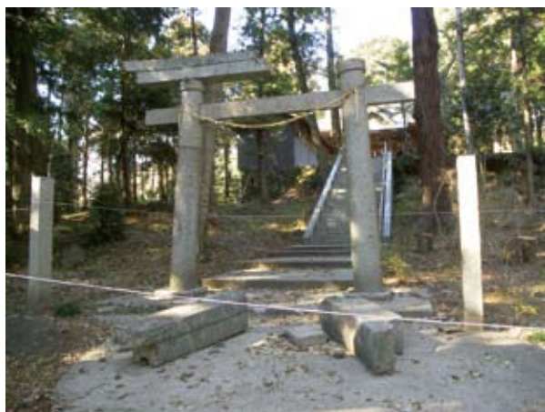
写真 2 飯名神社の鳥居の被災状況
