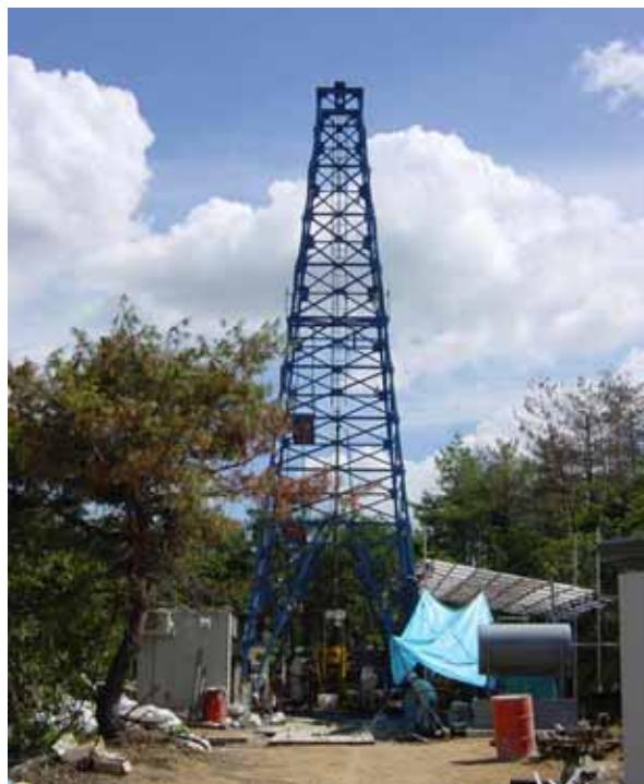
写真 1 岡山応力測定孔の掘削櫓
