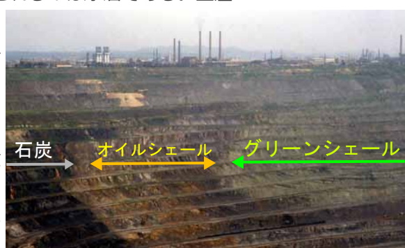
図1. 中国・撫順炭田西露天鉱。露天鉱の深さ約300m。
