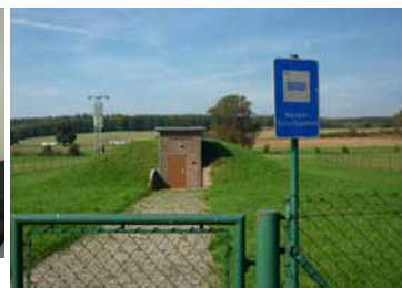
飲料水用揚水井（写真中央）の周囲は立ち入り禁止になっています。手前の看板は、“地下水保全域”と書かれています。
