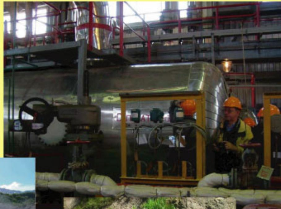
写真2 蒸気と热水を分離するセパレータ
