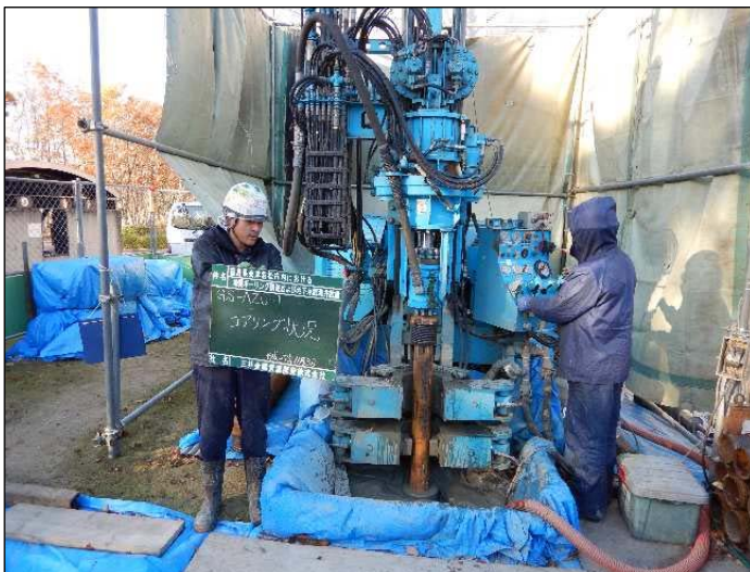
ボーリングによる地質資料採取 (深度100mまでのオールコアサンプリング)
