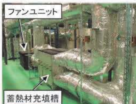
100kg級蓄熱材充填槽の試験装置
