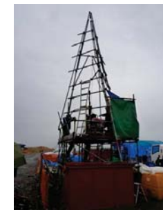
図1 掘削調査の様子
