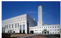
クリーンセンター廃熱利用
