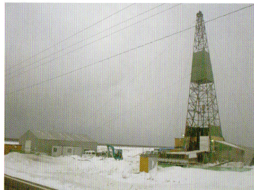
厳冬期の掘削現場写真
