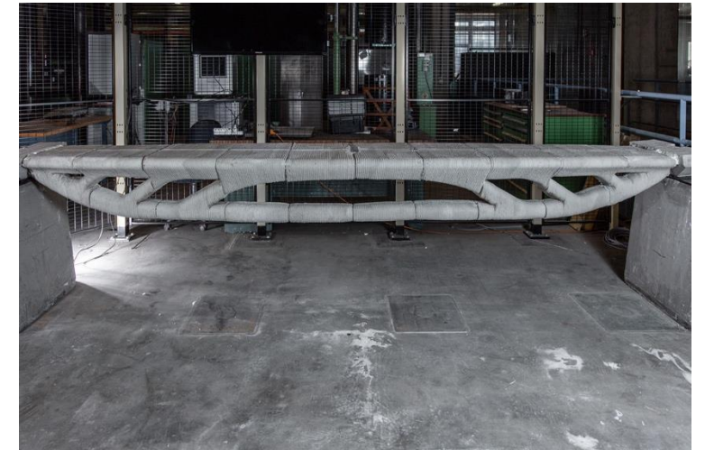
トポロジー最適化を用いて 設計された橋[5]
