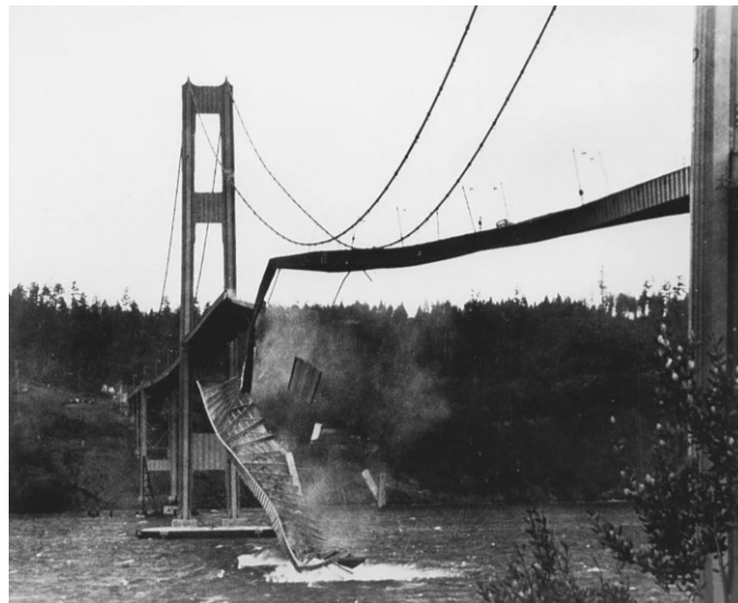
強風による共振により崩壊したタコマ橋（1940年） https://www.britannica.com/topic/Tacoma-Narrows-Bridge
