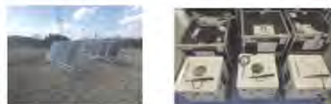
図4 2019年度阿武隈山系に設置予定の電源装置および鉛直ライダー
