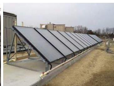
温度成層式予熱槽と、それに接続する太陽熱集熱パネル
