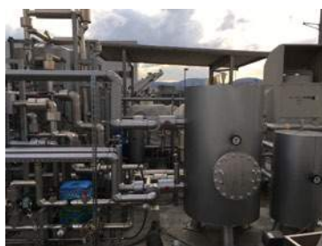
温度成層式予熱槽と、それに接続する太陽熱集熱パネル
