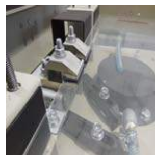
新規に設計したモジュール取付け金具
