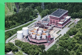
柳津西山地熱発電所（福島県河沼郡柳津町） (写真提供：東北電力株式会社)
