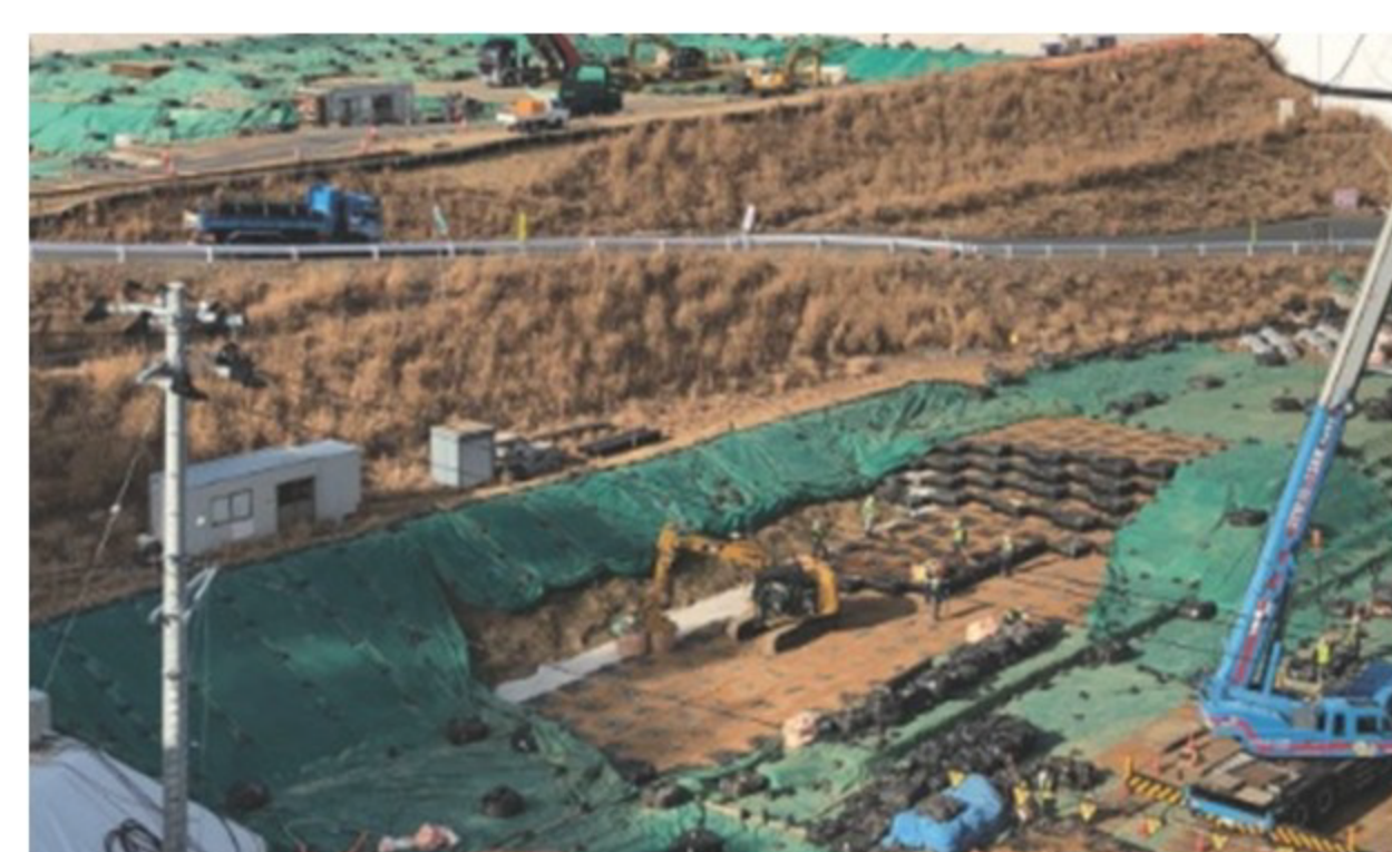
セラミック・ガラス製品は 多くが産廃として埋め立て
