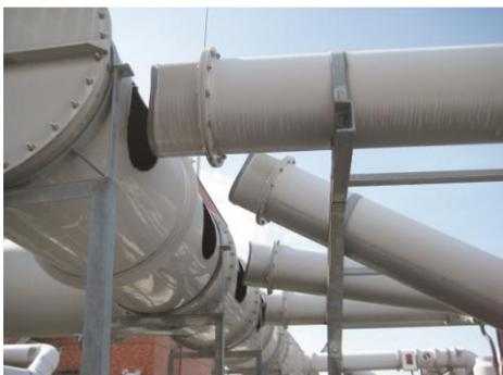
図 13 つくばセンター排ガス洗浄装置配管の損傷
