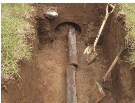
図 15 研究排水管が外れた箇所
