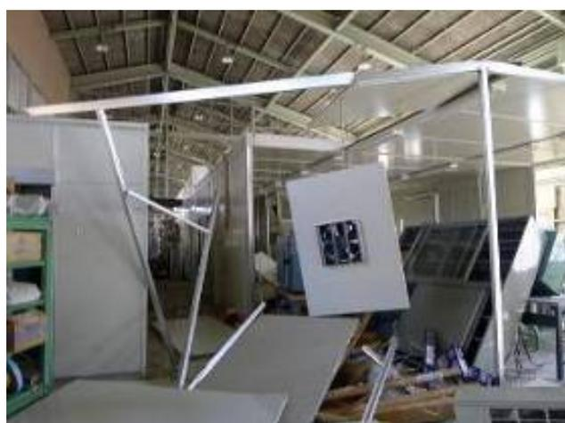
図 15 東北センター研究装置等の倒壊
