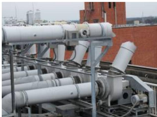
図 13 つくばセンター第五事業所排ガス処理設備ダクト破損
