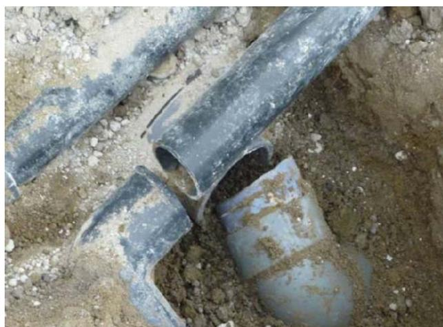
図 14 東北センター埋設配管のずれ
